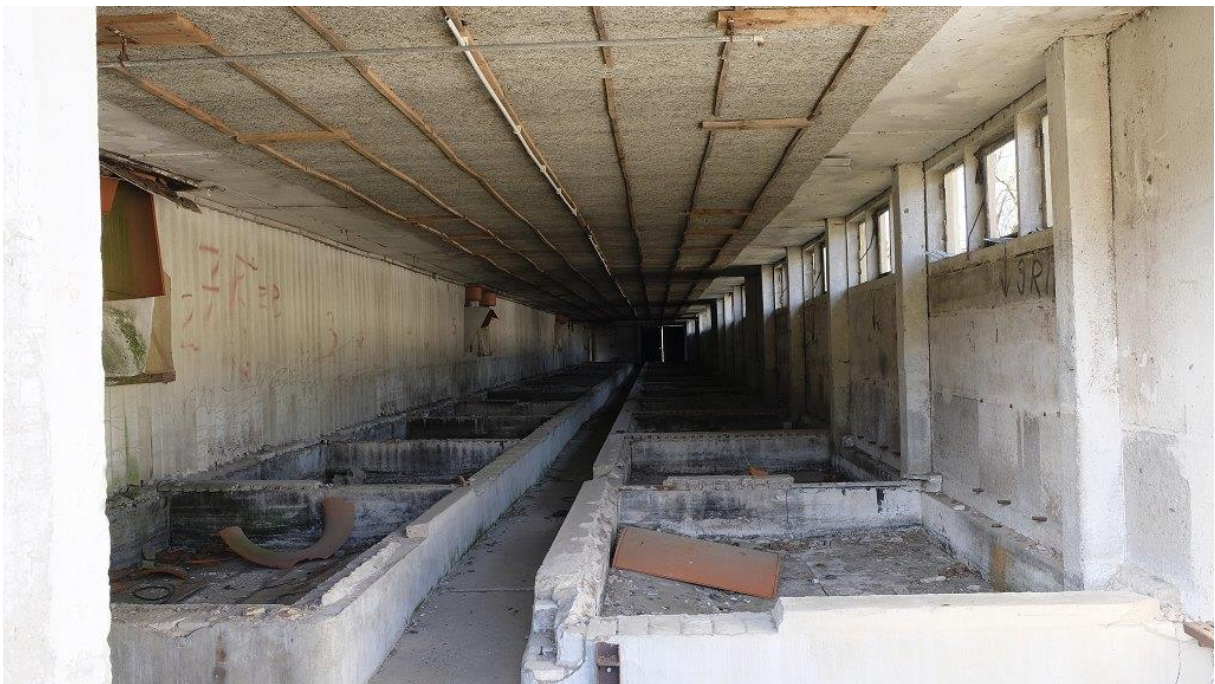
Abbildung 19 Gebäude Nr.5 von Innen
