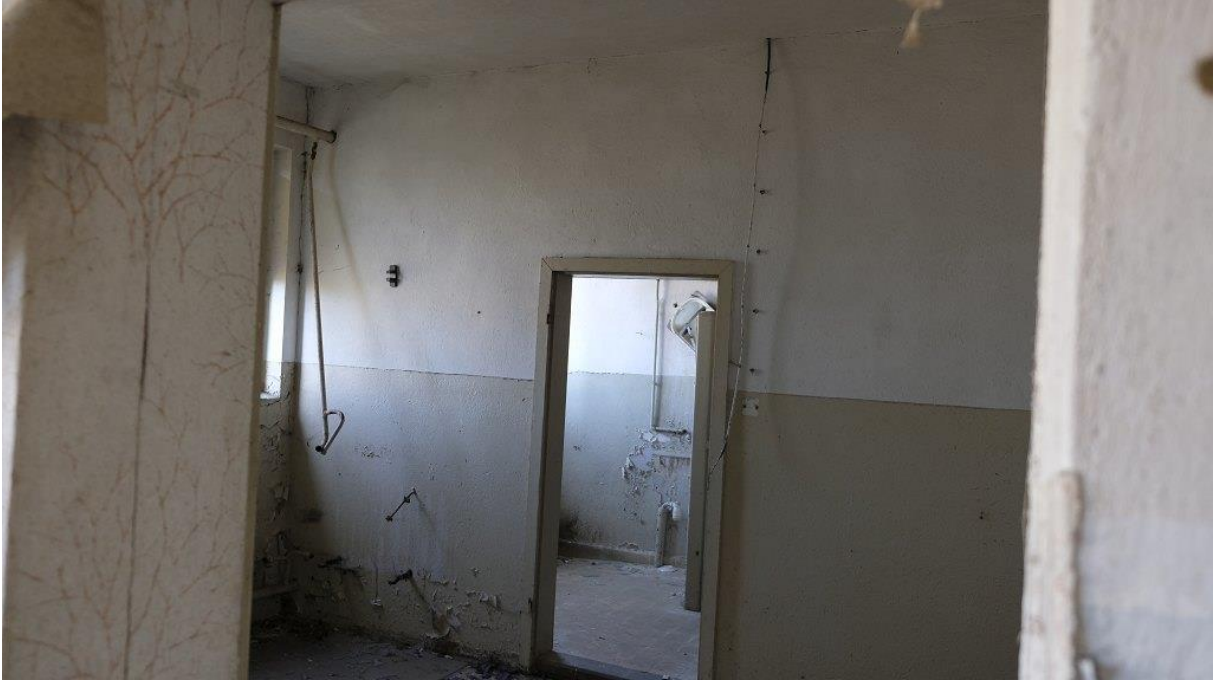
Abbildung 26 Im Bürogebäude (Nr.9)
