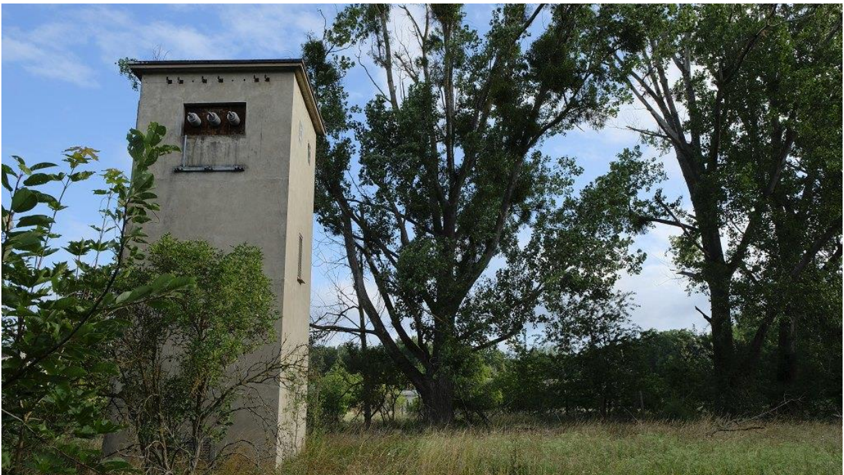
Abbildung 35 Trafoturm südlich außerhalb des Geltungsbereichs Haus Nr.12
