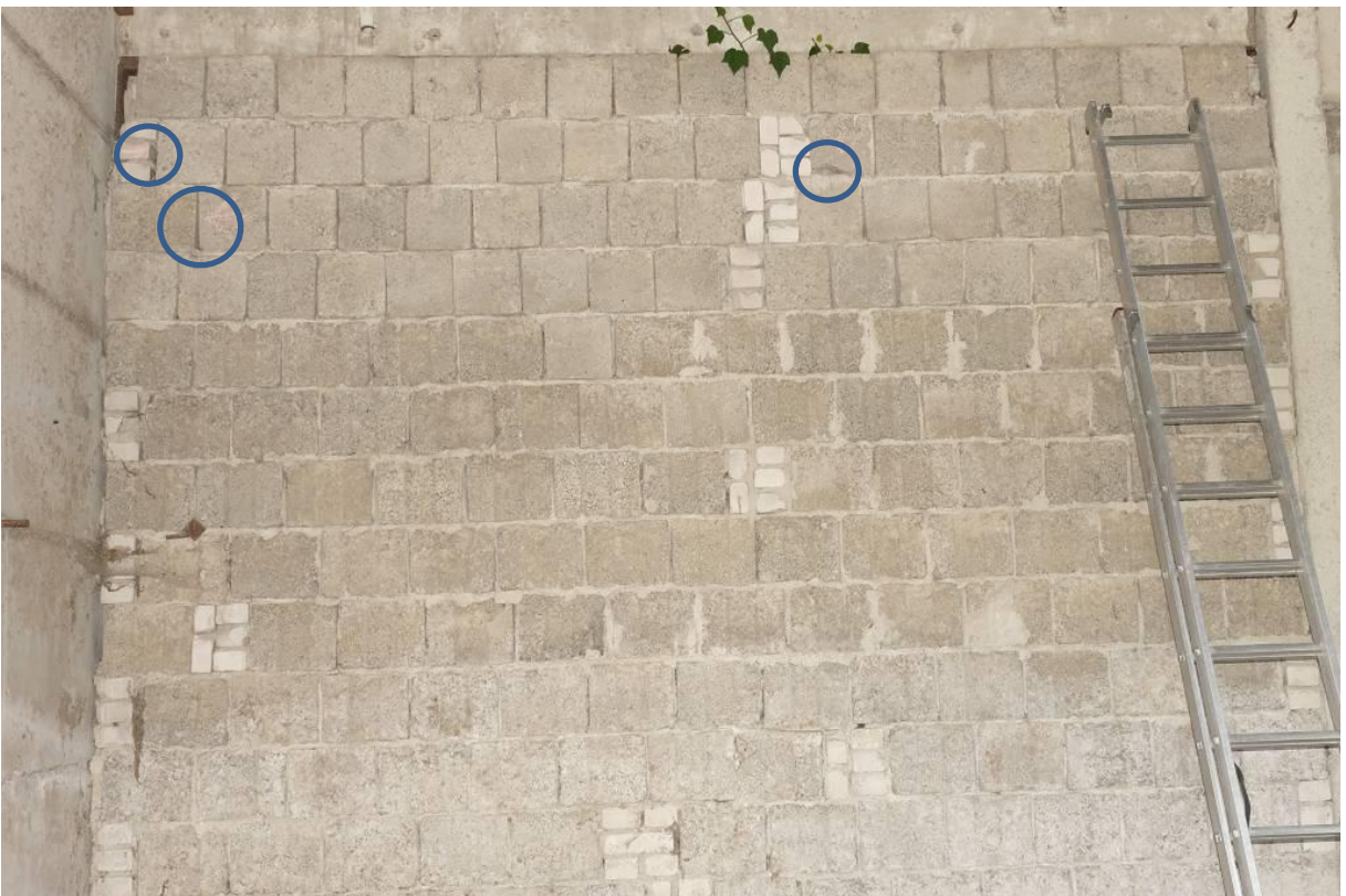
Abbildung 50 Seitenwand aus Hohlblocksteinen in Haus 6 (Westseite)
