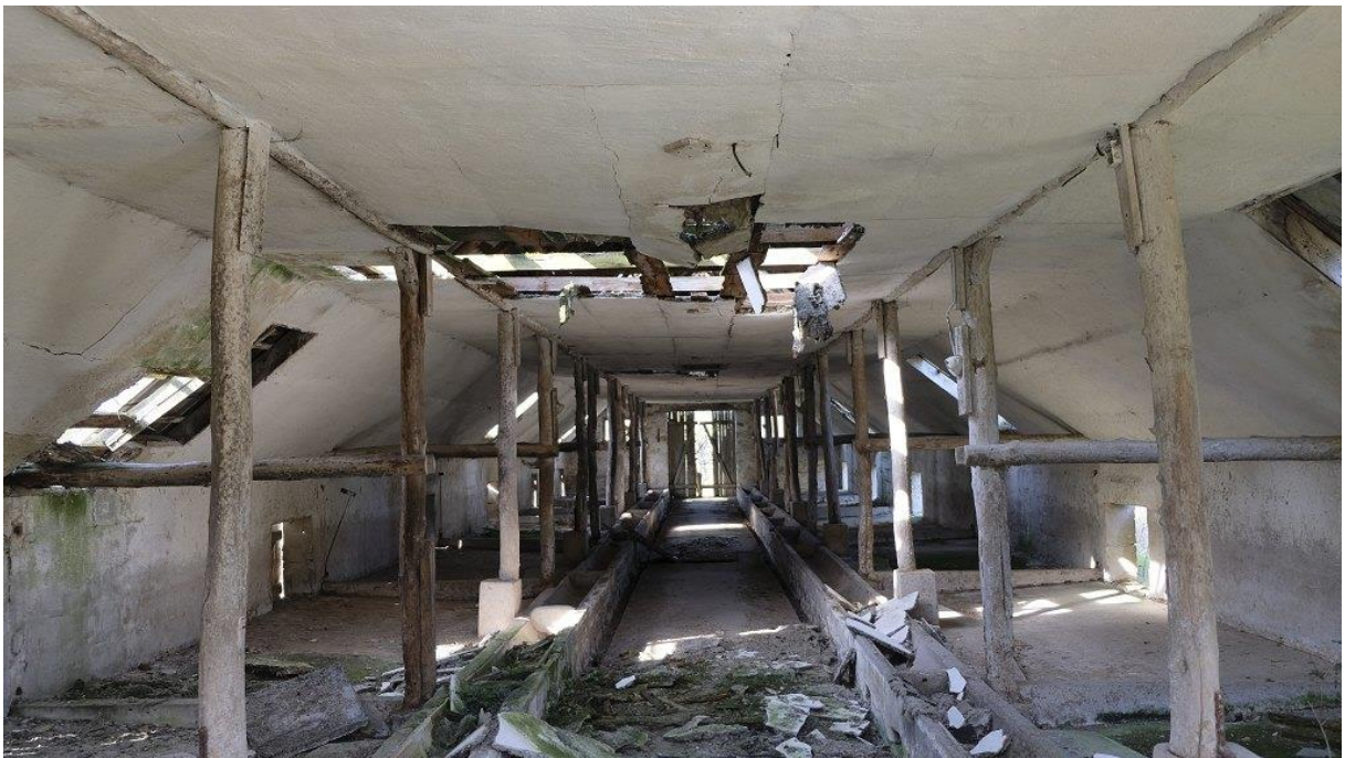
Abbildung 25 Blick in Gebäude Nr.10
