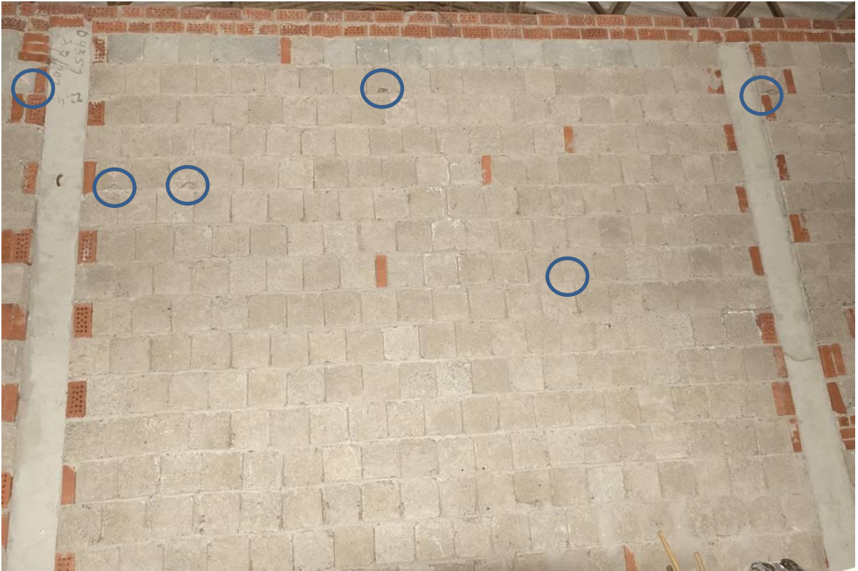
Abbildung 49 Trennwand in Haus 6 (Mitte) mit Fledermausquartieren (Kreis)
